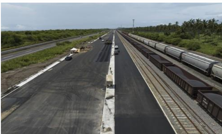
Carpeta Asfáltica en plataforma
