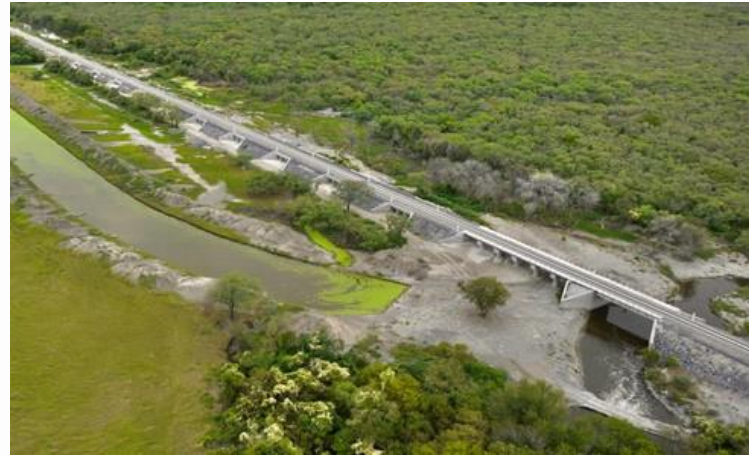
Puente Ayancual Km MF 13+200
