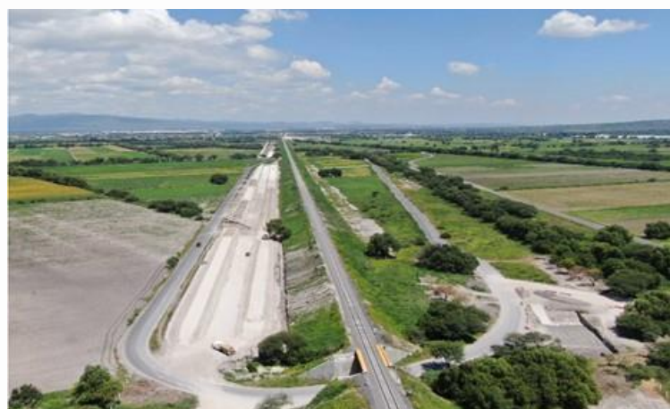
Canales Pluviales Norte y Sur
