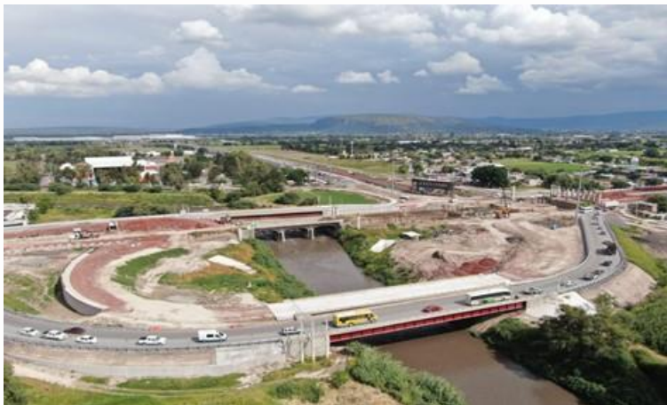
Vista general Distribuidor Vial Celanese
