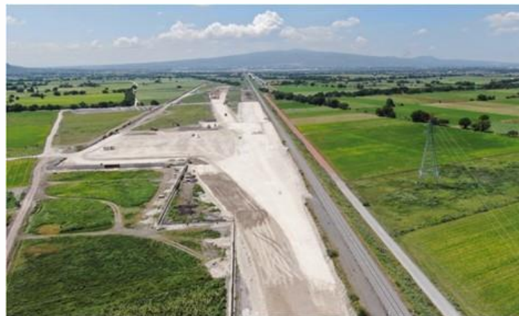
Terracerías Patio Operativo
