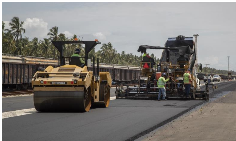
Carpeta Asfáltica en plataforma
