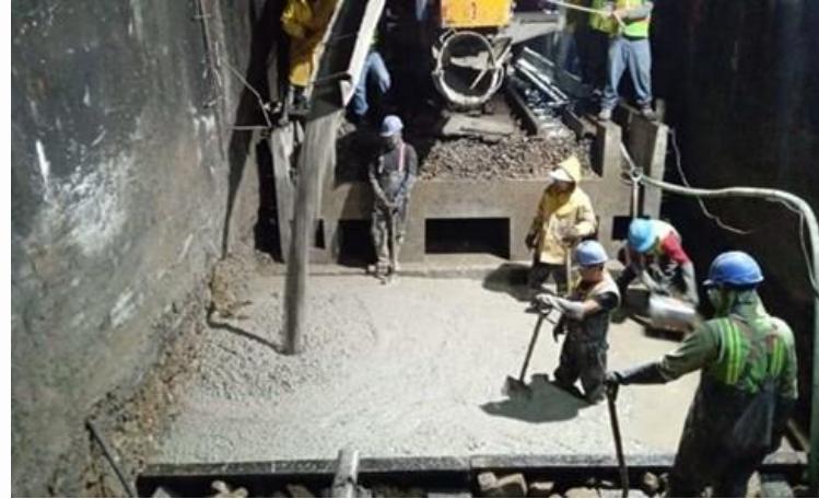
Colado con concreto de fraguado rápido
