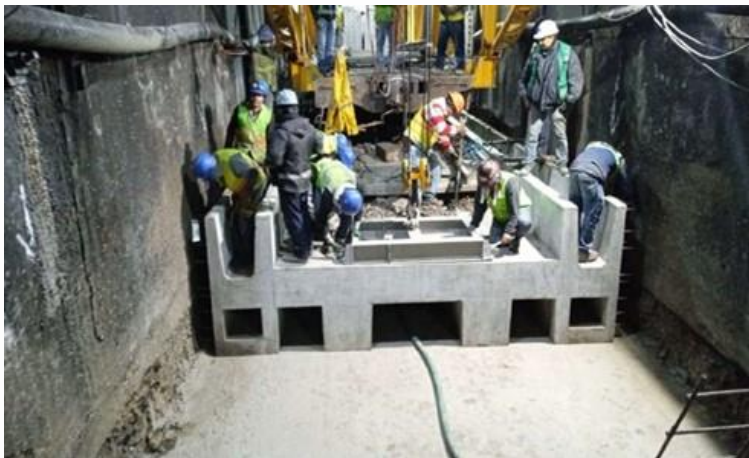
Colocación de prefabricados
