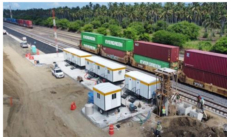
Plataforma de concreto y oficinas móviles
