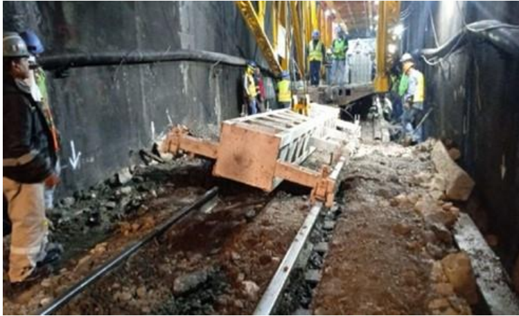
Retiro de vía existente para excavación
