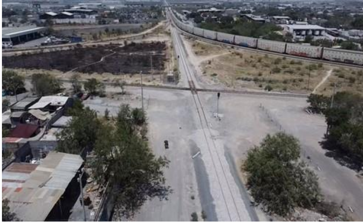
Crucero Ferroviario Línea "BF-B"
